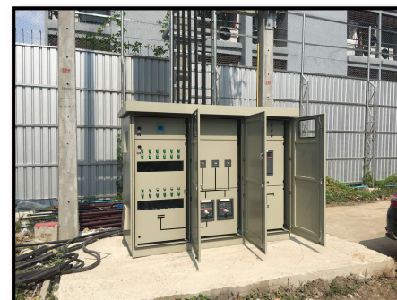
ตัวอย่างการติดตั้งใช้งาน SFERE CAPACITOR BANK
