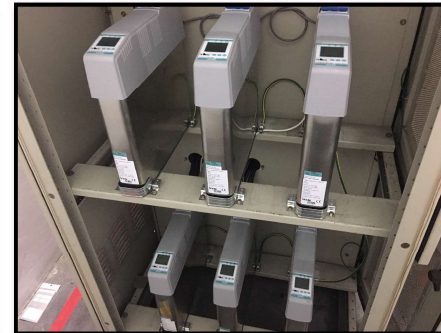
ตัวอย่างการติดตั้งใช้งาน SFERE CAPACITOR BANK
