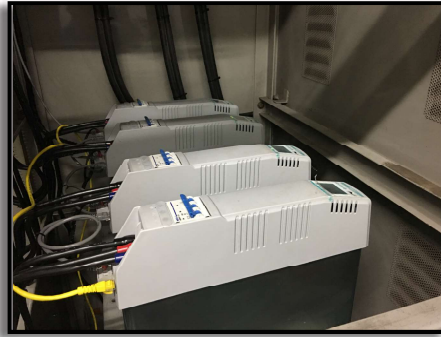
ตัวอย่างการติดตั้งใช้งาน SFERE CAPACITOR BANK
