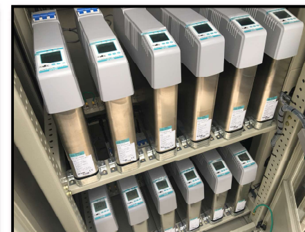
ตัวอย่างการติดตั้งใช้งาน SFERE CAPACITOR BANK
