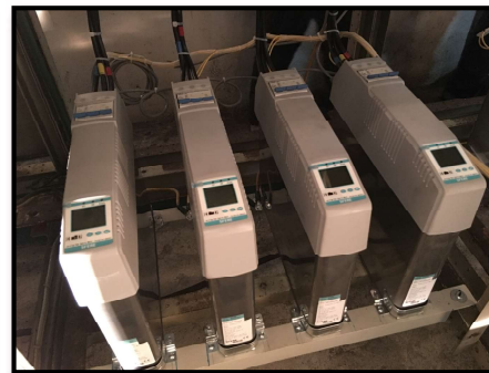
ตัวอย่างการติดตั้งใช้งาน SFERE CAPACITOR BANK
