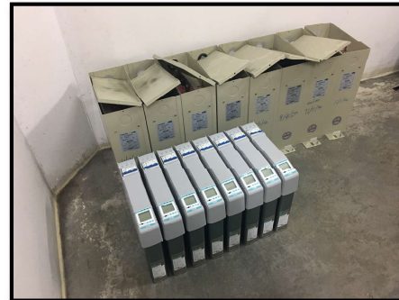
ตัวอย่างการติดตั้งใช้งาน SFERE CAPACITOR BANK
