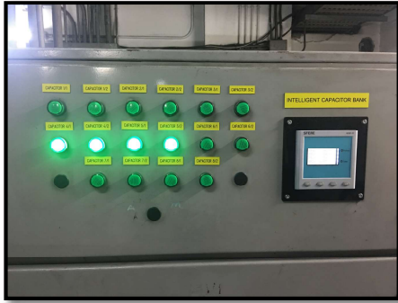
ตัวอย่างการติดตั้งใช้งาน SFERE CAPACITOR BANK
